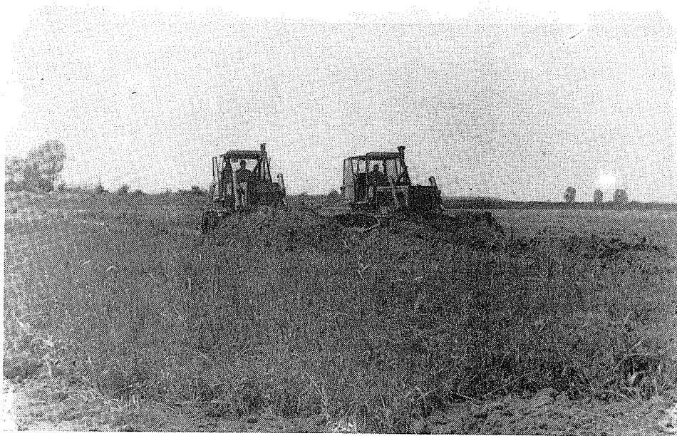
Slika 9 RAD DOZERA (TG-100) NA OTKOPU I RAZASTIRANJU HUMUSA (ZA IZGRADNJU ZEMLJANIH PUTOVA U SKLOPU IZVEDBE MREŽE MELIORACIJSKIH KANALA - NA PODRUČJU OPĆINE OSIJEK)
